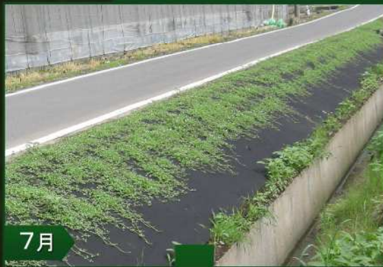
通根性防草シート施工例
